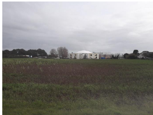
Photographie 2 : Vue sur le centre nautique au sud depuis le site (Source : BURGEAP, 19/02/2020)
